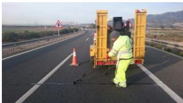
Fotos 10 y 11. La aplicación del sellado deberá realizarse inmediatamente después del soplado y calentamiento de la fisura. En este caso este caso el tipo de sellado es de "configuración tipo banda"
