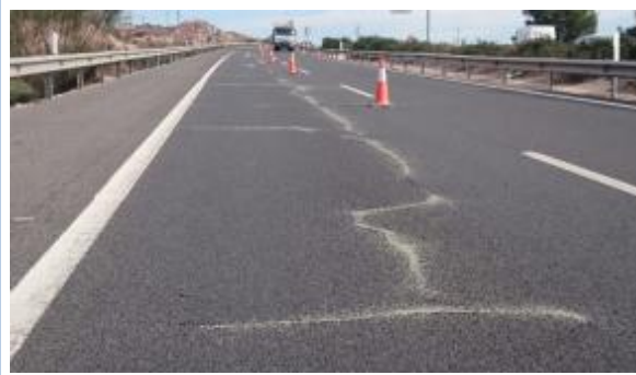
Fotos 12 y 13. Inmediatamente después de la aplicación del producto de sellado a lo largo de la fisura se extenderá el árido de cobertura, sobre toda la superficie, en la dotación adecuada, su exceso deberá retirarse de la calzada mediante barrido o aspiración, antes de abrir el tramo reparado.
