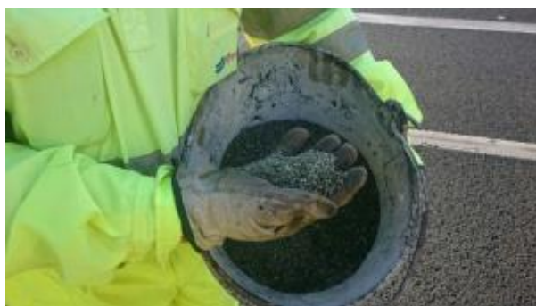
Fotos 12 y 13. Inmediatamente después de la aplicación del producto de sellado a lo largo de la fisura se extenderá el árido de cobertura, sobre toda la superficie, en la dotación adecuada, su exceso deberá retirarse de la calzada mediante barrido o aspiración, antes de abrir el tramo reparado.
