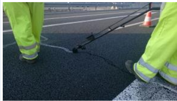
Fotos 10 y 11. La aplicación del sellado deberá realizarse inmediatamente después del soplado y calentamiento de la fisura. En este caso este caso el tipo de sellado es de "configuración tipo banda"
